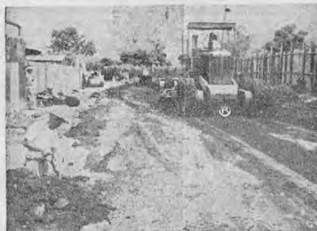
Equipo municipal procede a la ampliación de la Avenida Sexta que era bis. La nueva Avenida tiene una extensión de 400 varas, arrancando en el Plantel de Obras Públicas.
